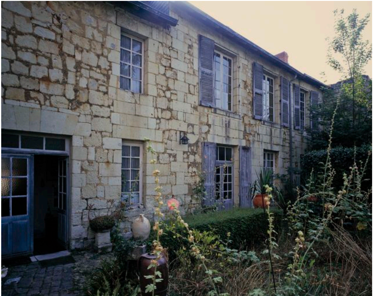
Détail de la façade, avant restauration (en 1996).
