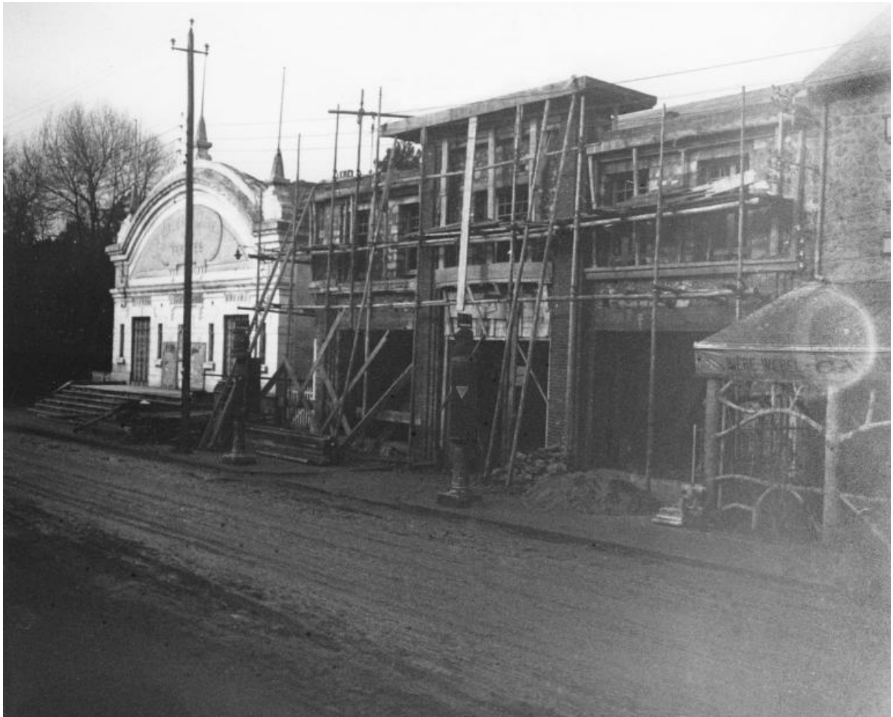
Construction du garage Minot (1928).
