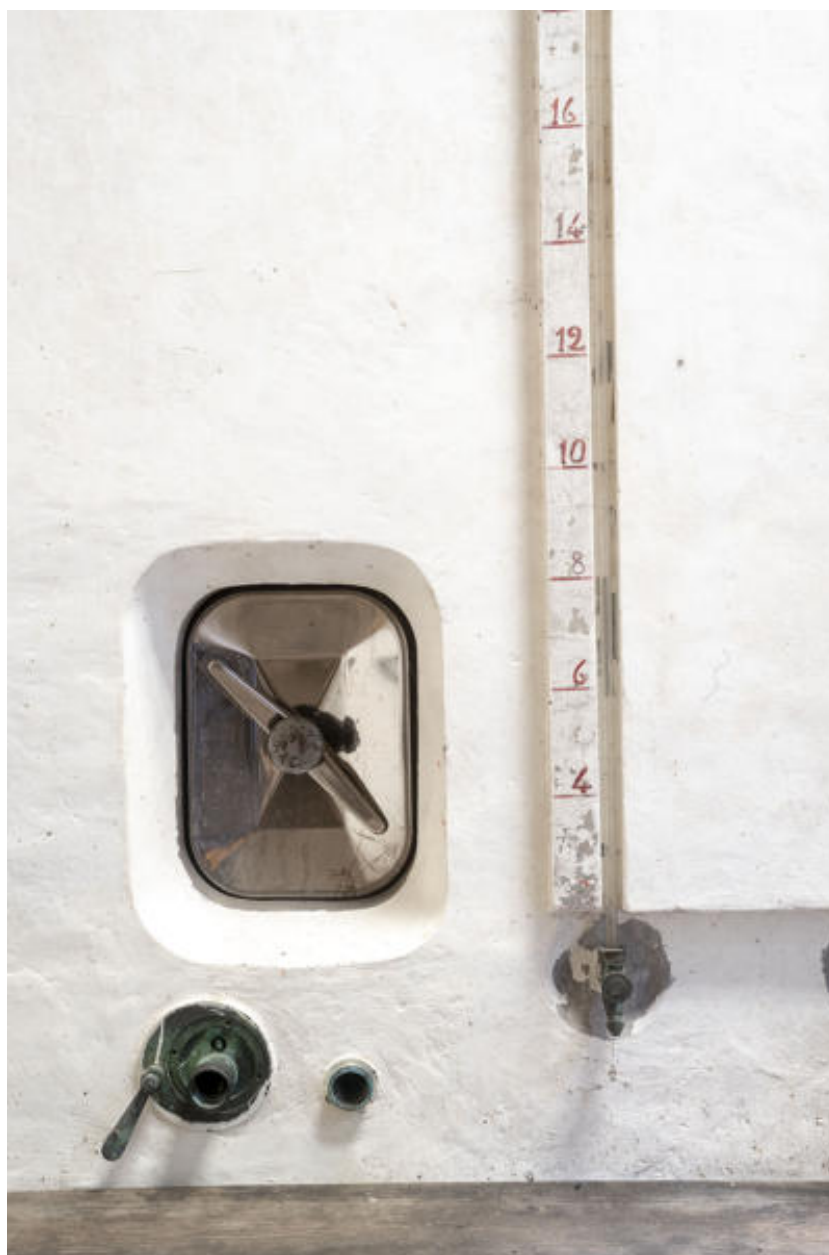
Détail de la cuverie, au premier étage.
