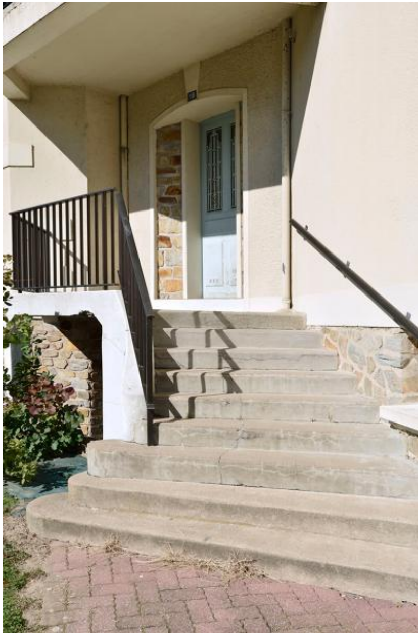
Détail de l'entrée de l'immeuble au 18 rue du Docteur-Baruck.
