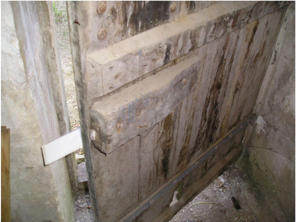
Serrure en bois de la porte de la remise, observée en 2006.
