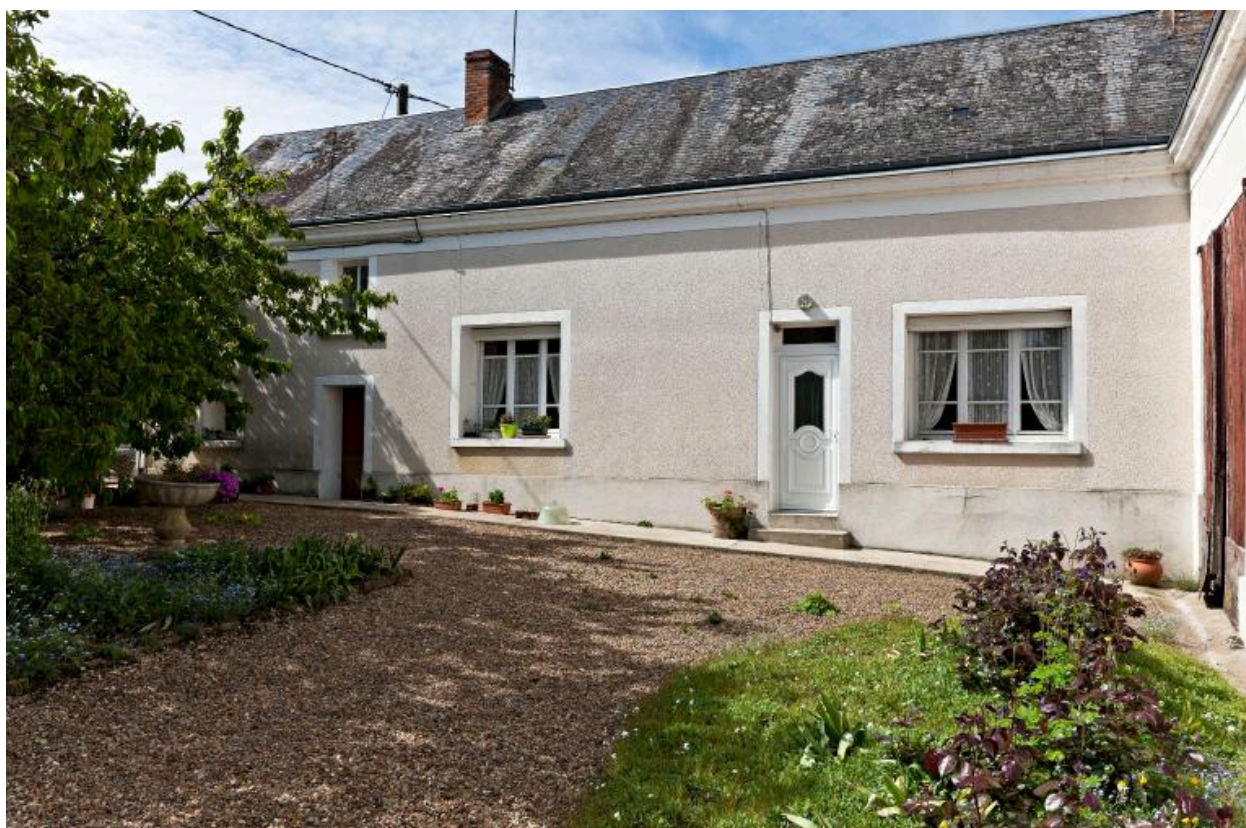
Maison, façade antérieure sur cour.
