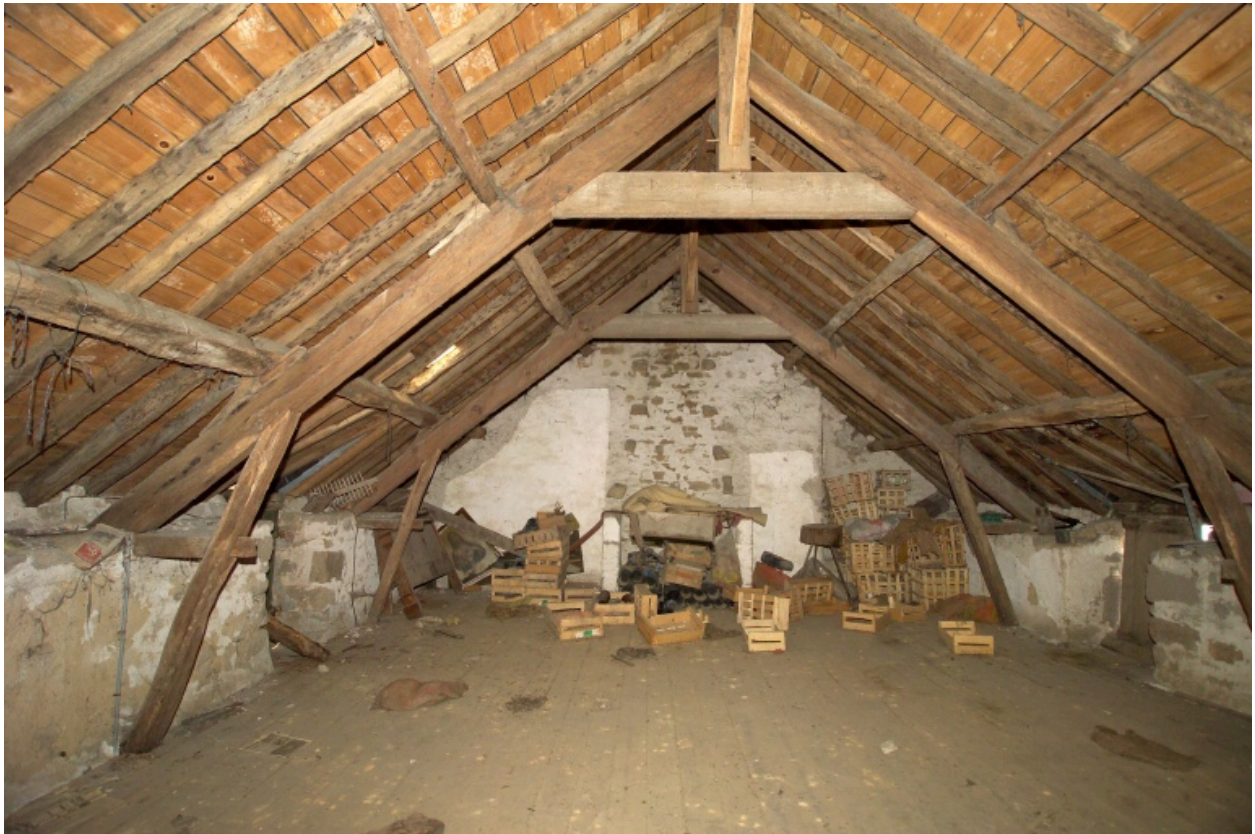
Comble vu vers l'Ouest.
