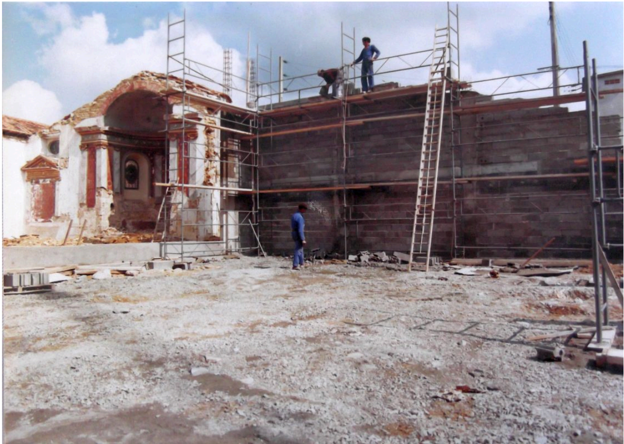
Construction du mur est de la nouvelle église, printemps 1974.
