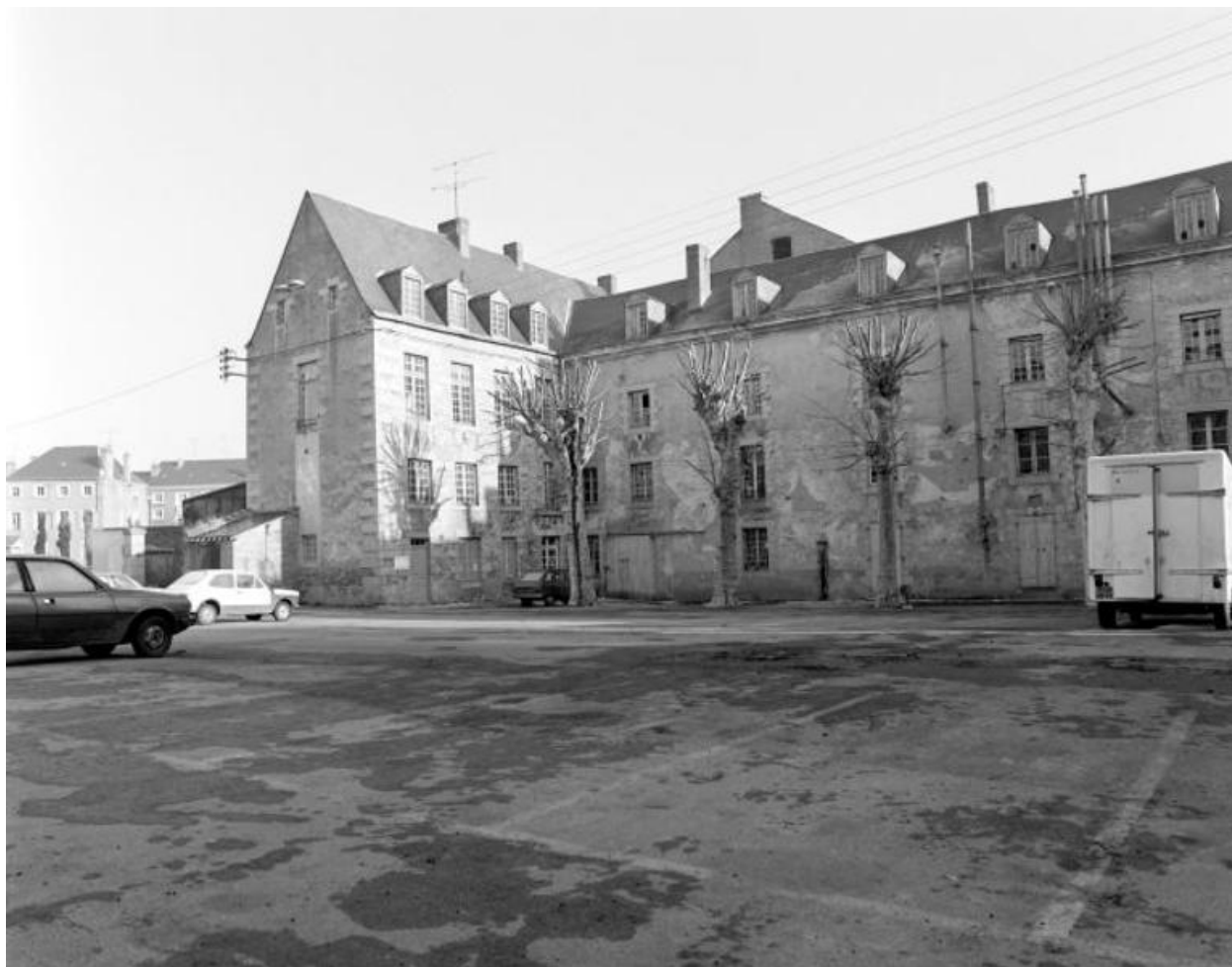
Couvent, corps de logis nord-est et aile en retour, élévation intérieure : vue d'ensemble.
