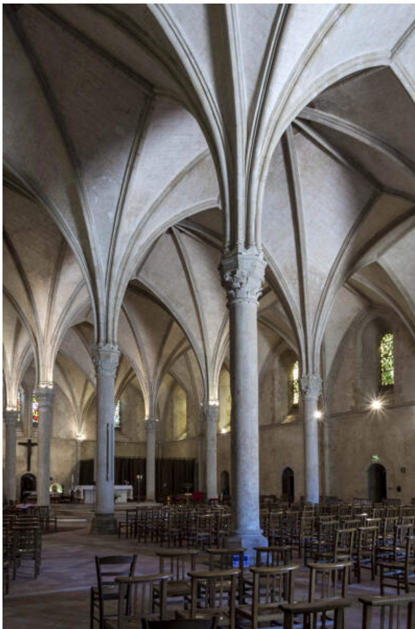
Vue de la nef depuis le nord-ouest.
