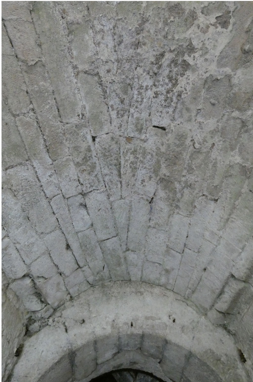
Voûte de la trappe de défournement.
