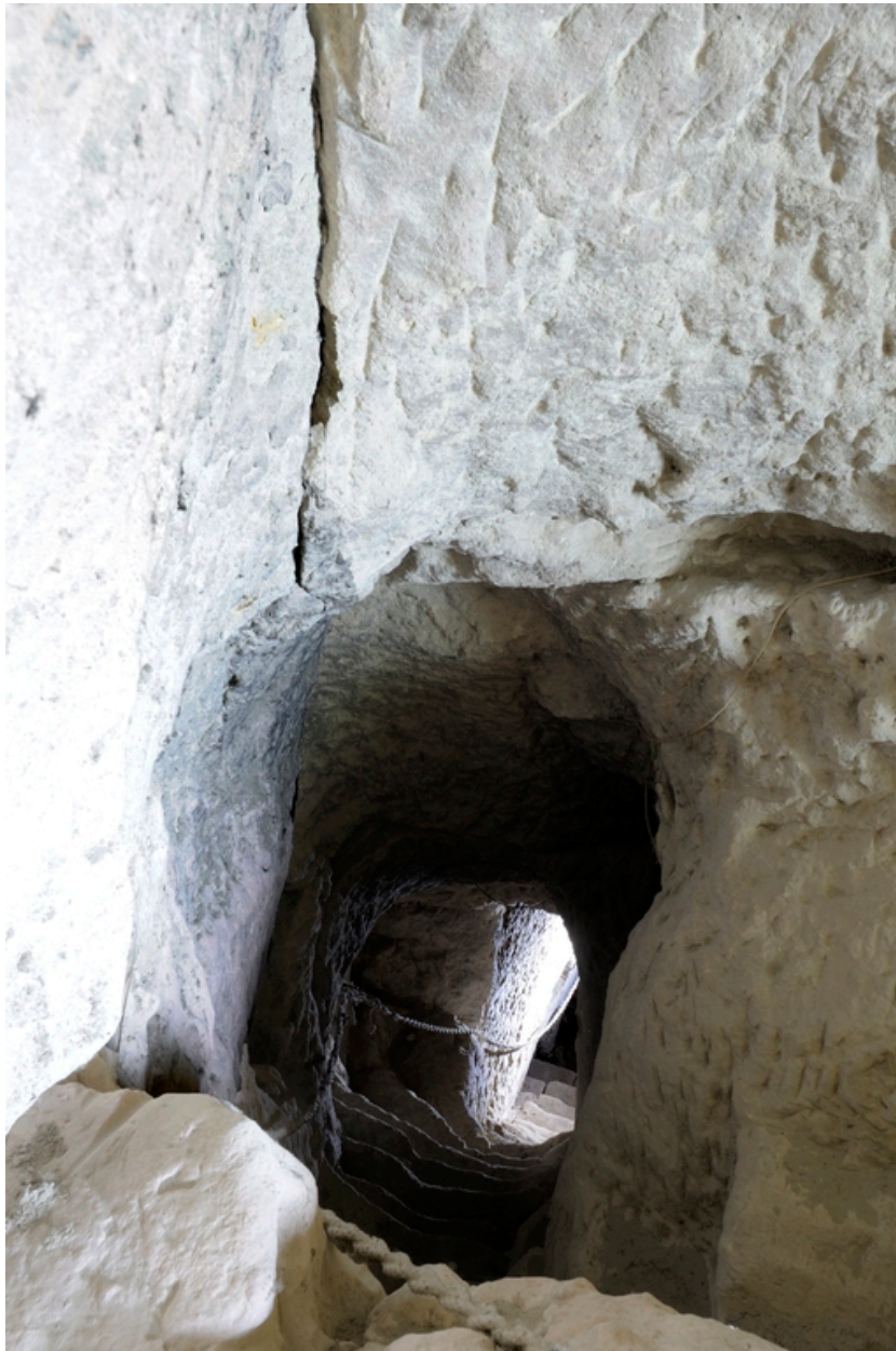
Débouché des escaliers, dans la salle haute.
