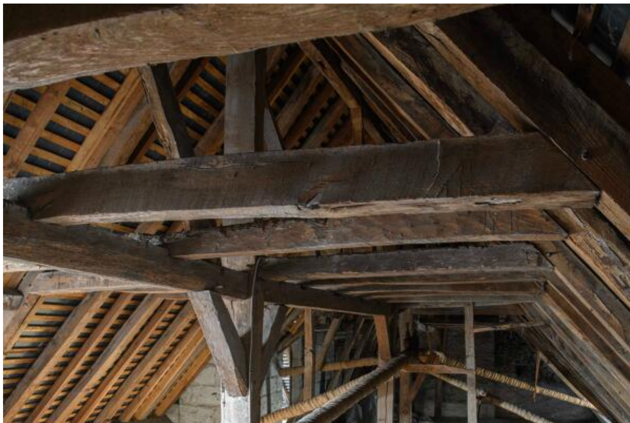
Vue d'ensemble du comble, corps principal, partie est, Petit Château, Montjean-sur-Loire.
