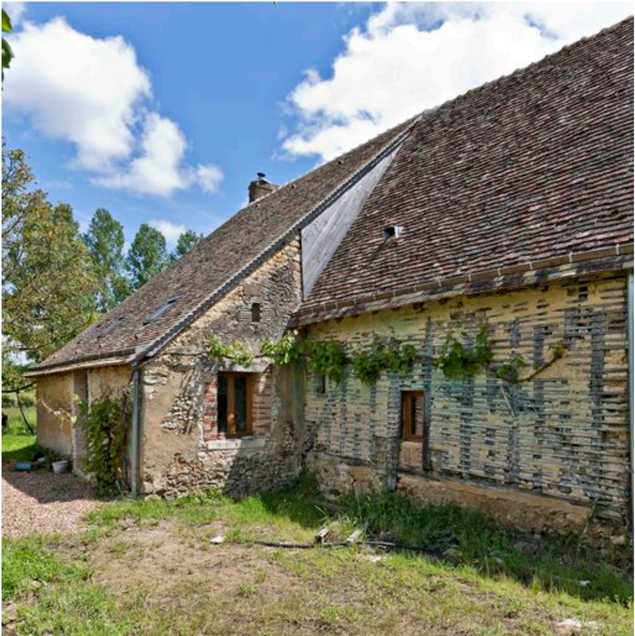
Elévations postérieures du logis (laiterie) et des étables.
