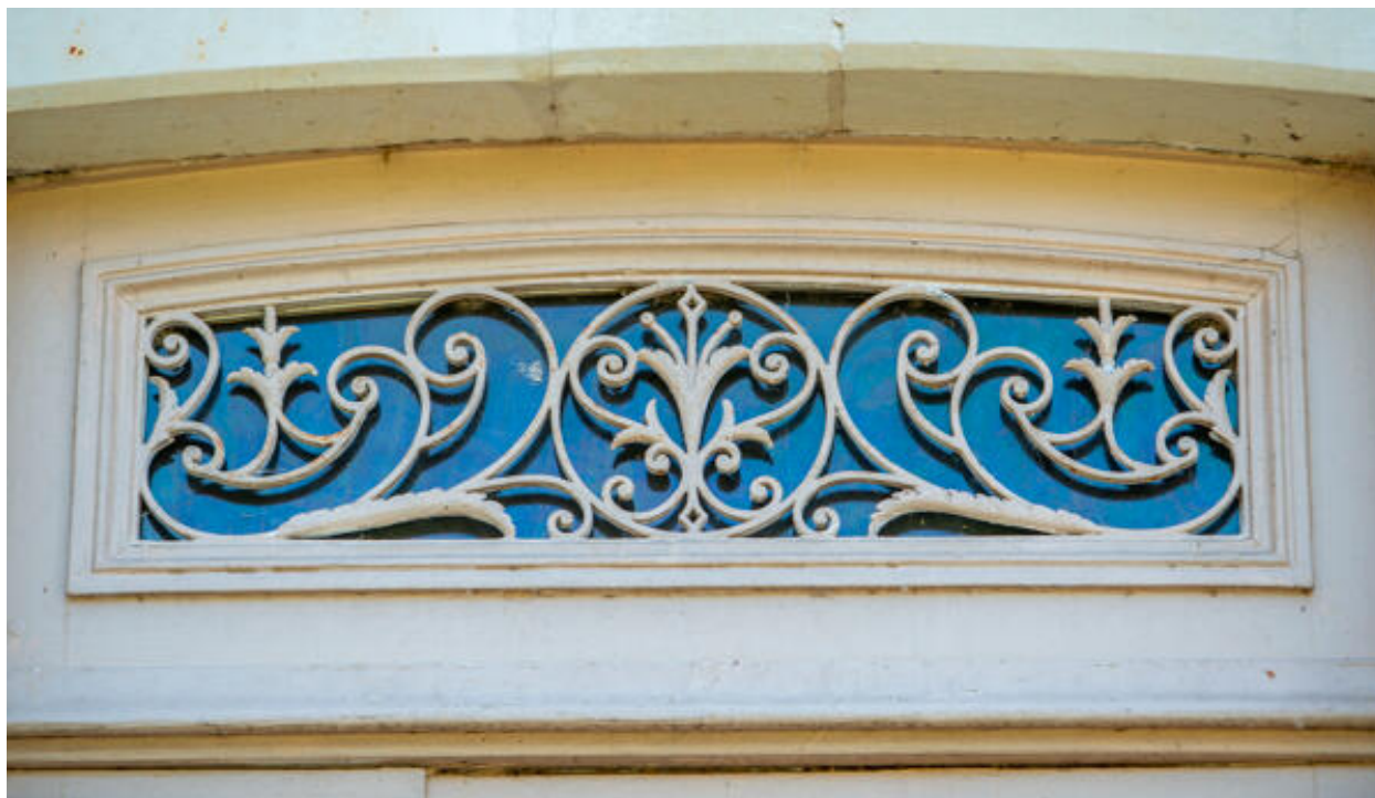
La porte de l'élévation postérieure, détail.
