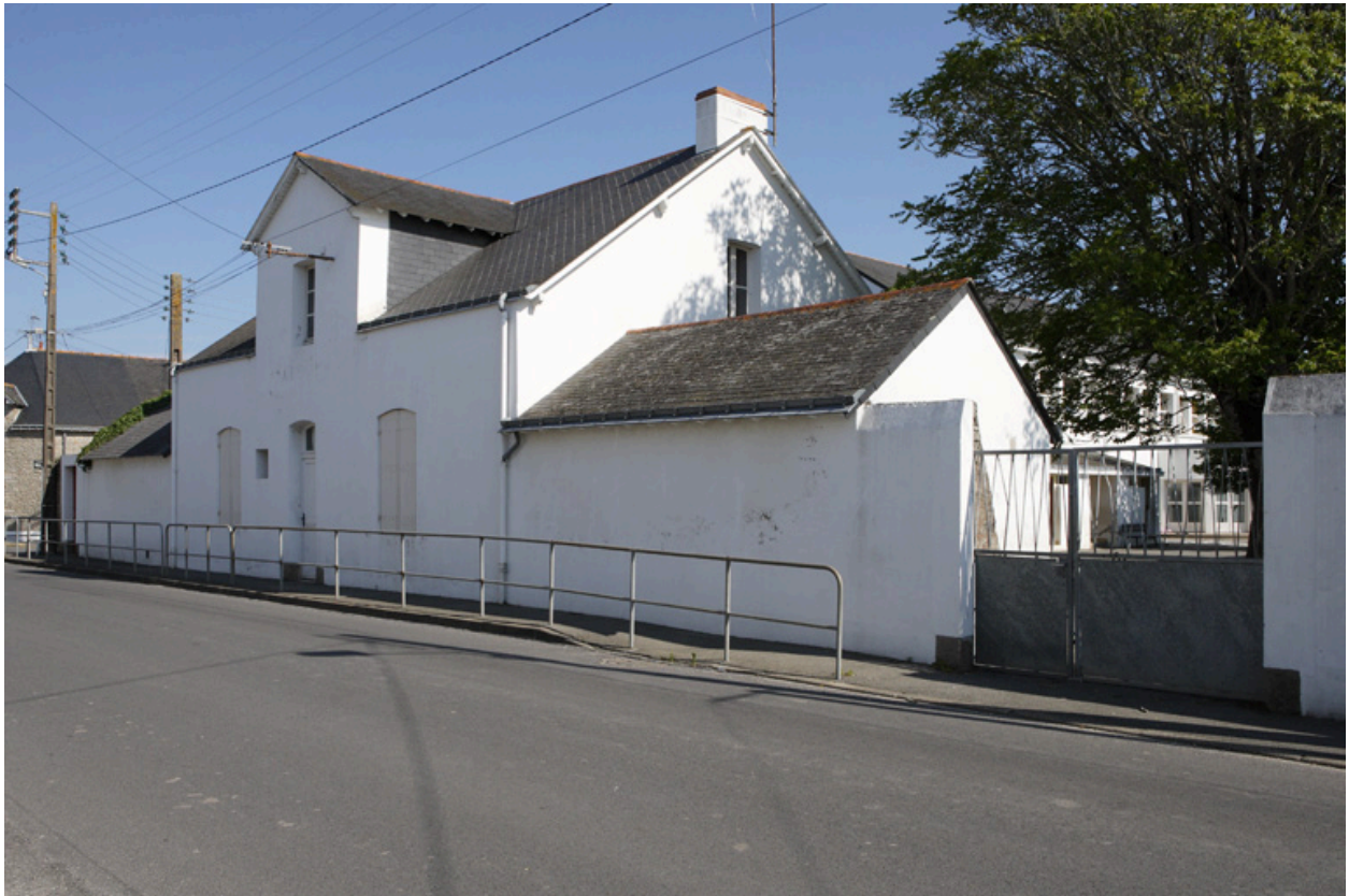
Vue de la façade sur la rue Saint-Exupéry depuis le sud-est.
