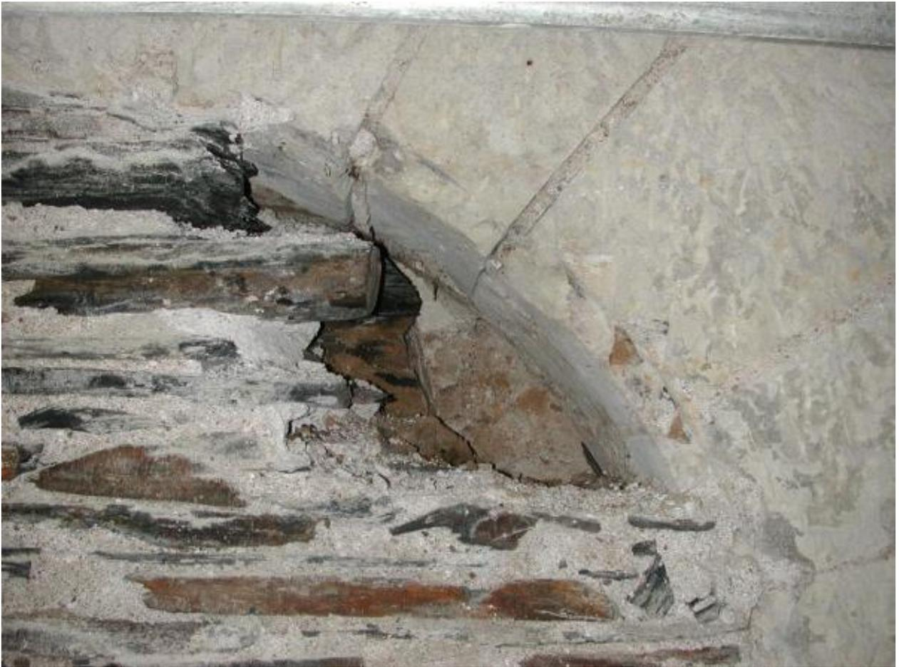
Logis principal, aile droite, pignon sur rue, 1er niveau, baie romane de droite, partie supérieure droite : décor de ruban plissé sur le front de l'arc et trace d'un remplage
