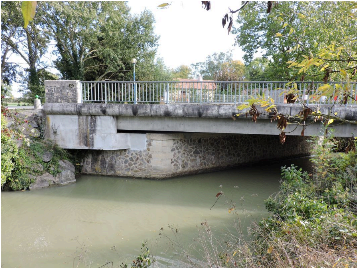
Le pont des années 1950, vu depuis le nord, côté amont.
