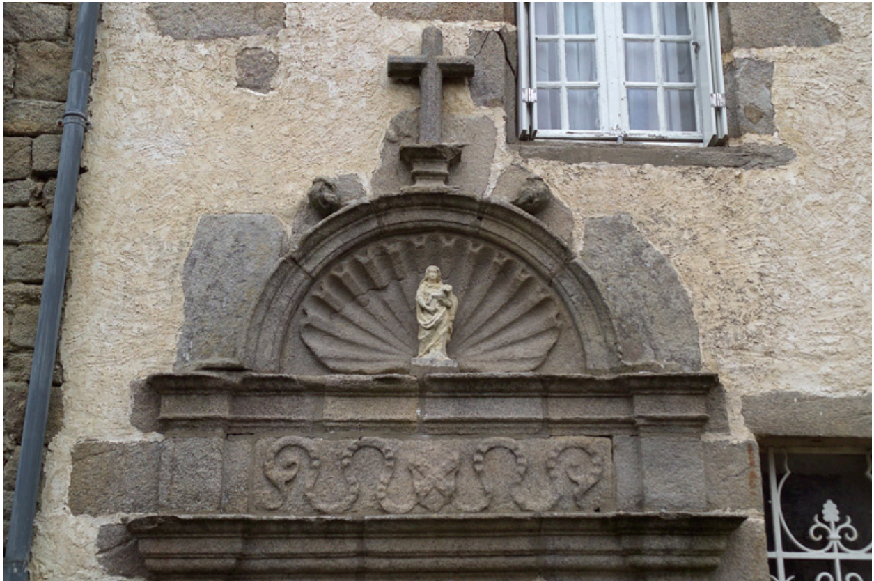
Façade sud, porte centrale : détail de la partie haute.
