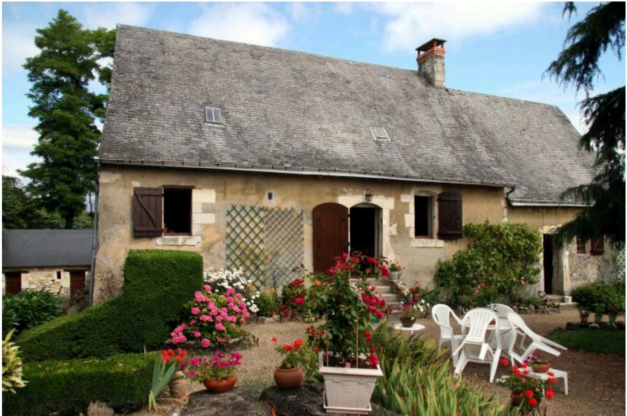
Façade sud : maison au rez-de-chaussée surélevé.
