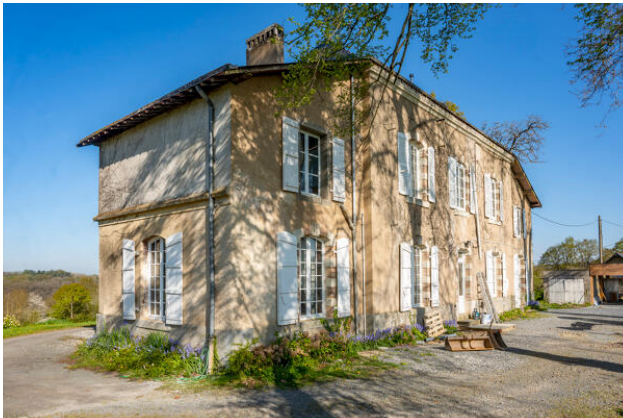
La façade postérieure de la maison.
