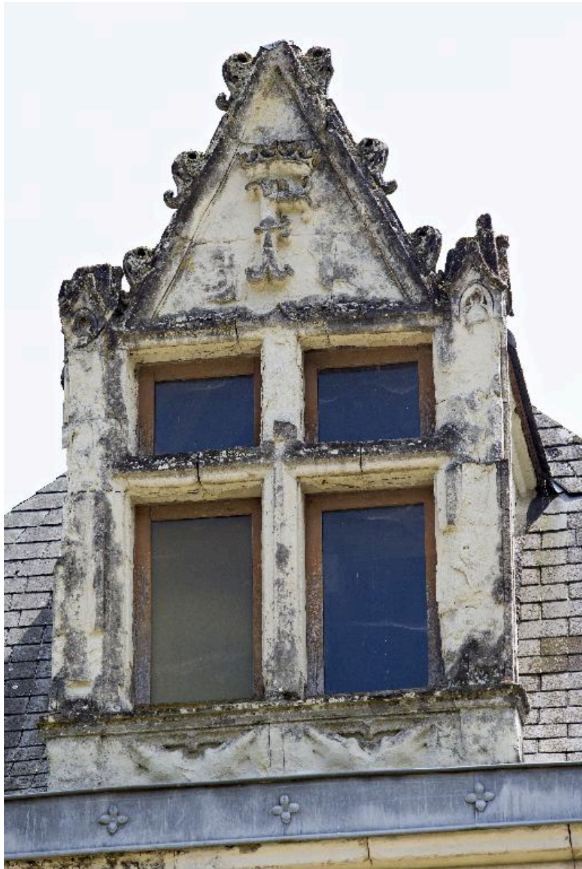
Lucarne du pavillon est, face sud.
