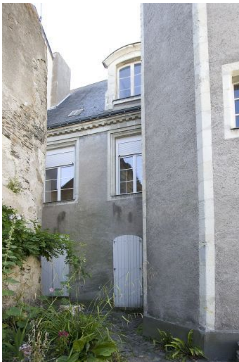
Elévation antérieure, partie à gauche de la tour d'escalier.
