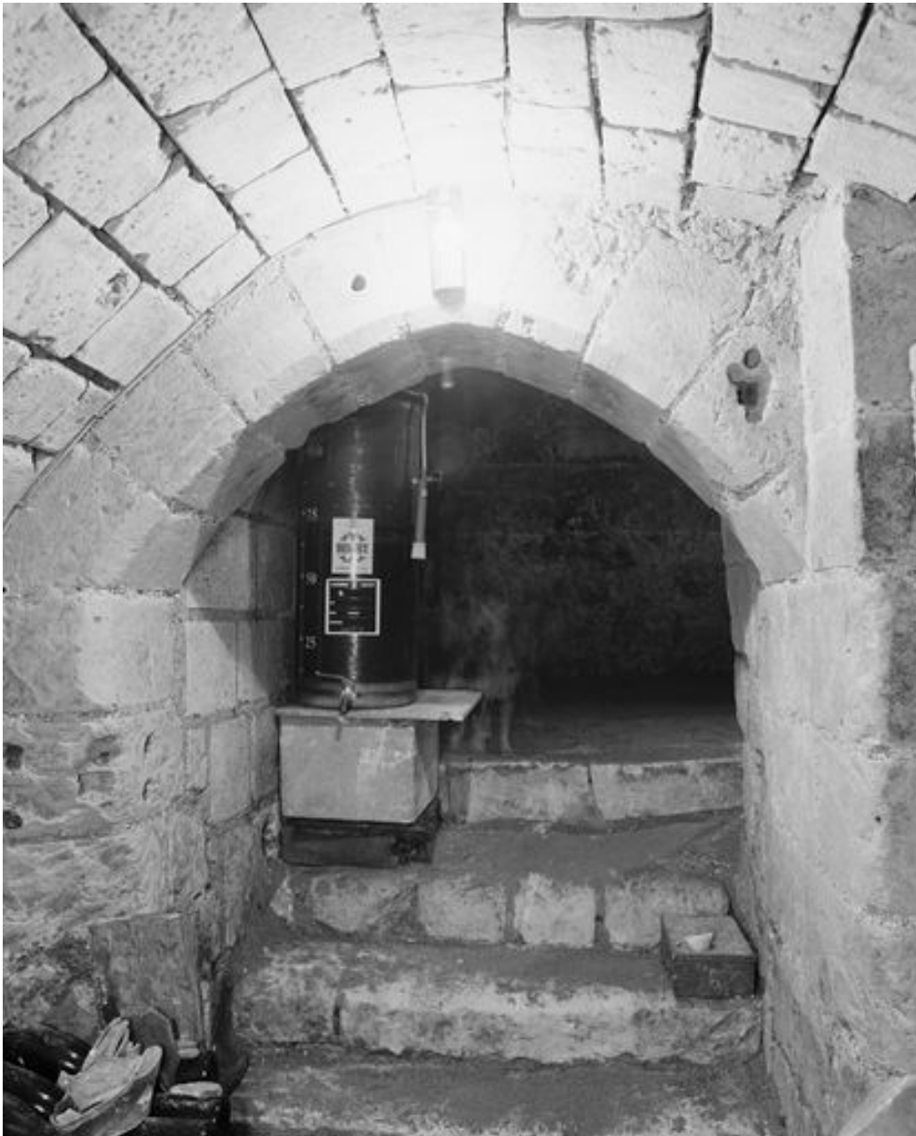
Sous-sol, porte à couverture en arc brisé et chanfreiné.
