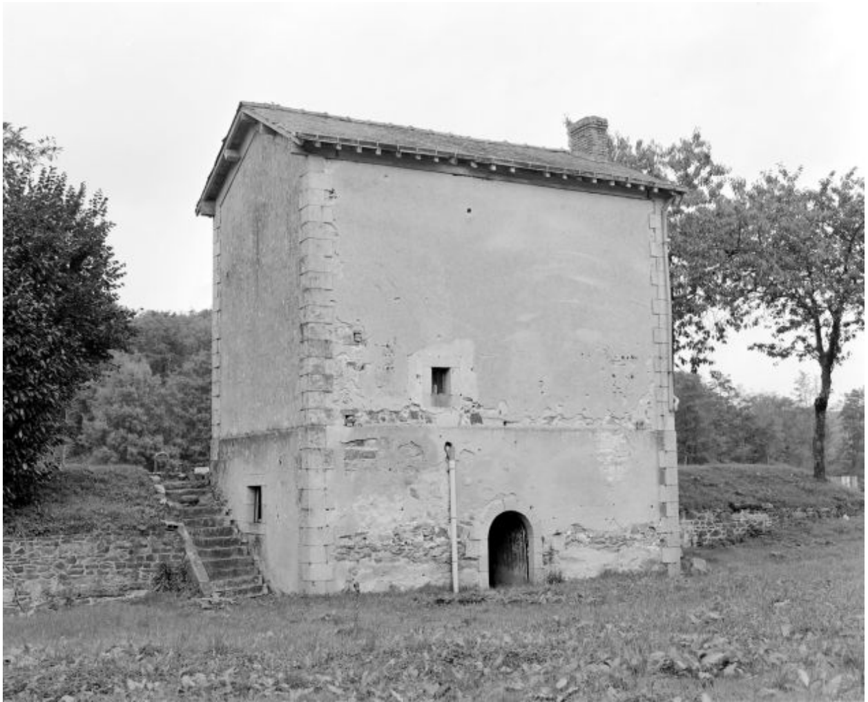
Façade postérieure de la maison éclusière.
