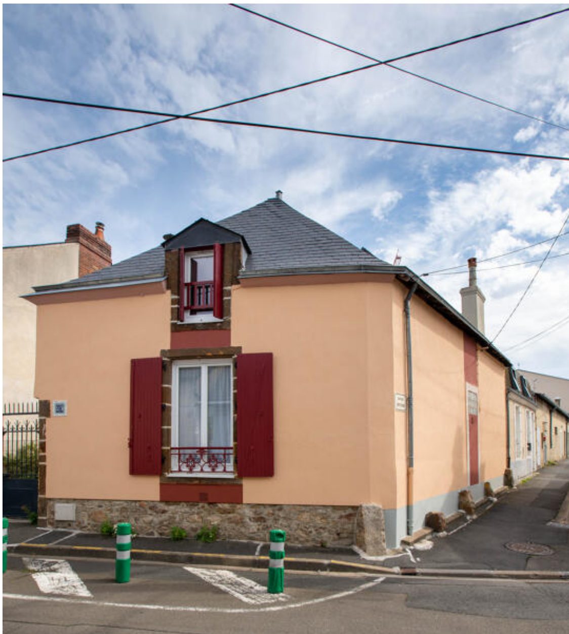
Vue du pignon de la maison longeant l'impasse Desforges.
