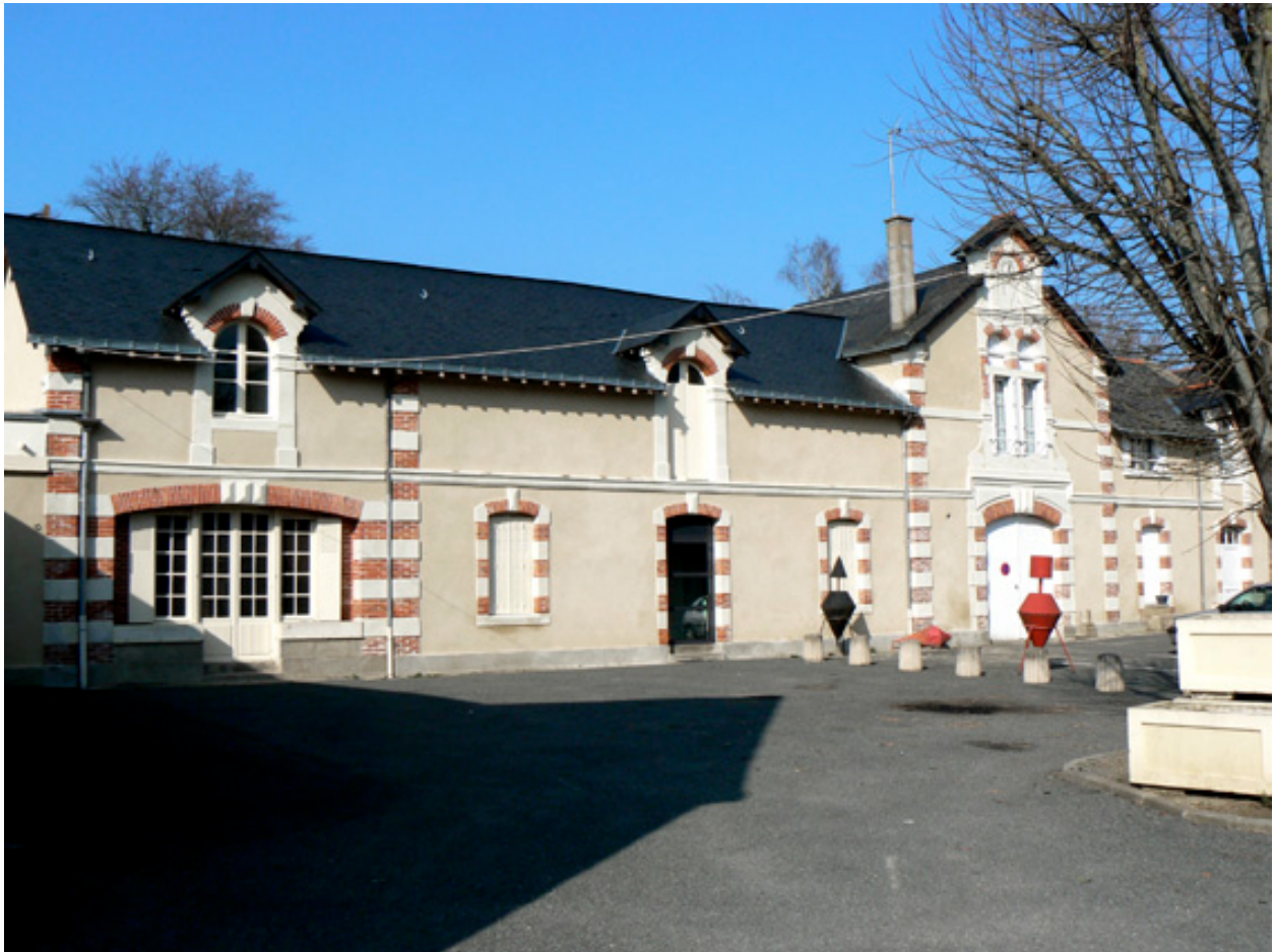
Anciens bâtiments de stockage, daté 1873 (Bâtiment nord-ouest D ; face sud-est).
