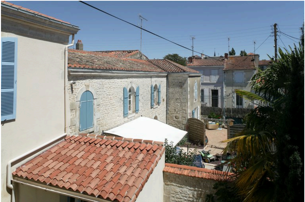
Vue de l'aile de communs située au nord de la cour, aménagée en demeure.
