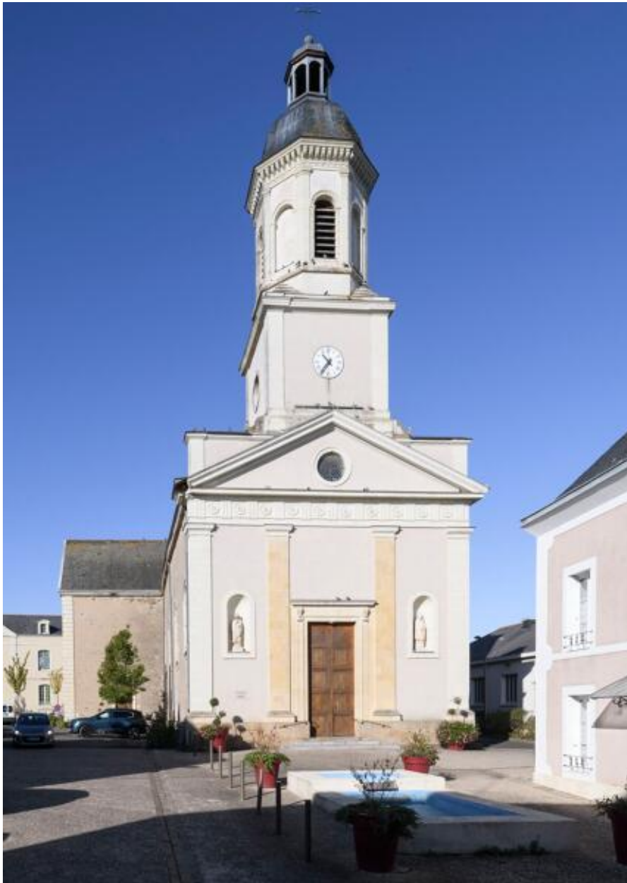
Vue de la façade orientale.
