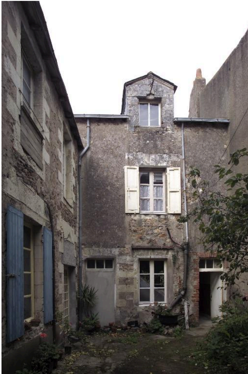
Maison, 3 quai Gautreau.
