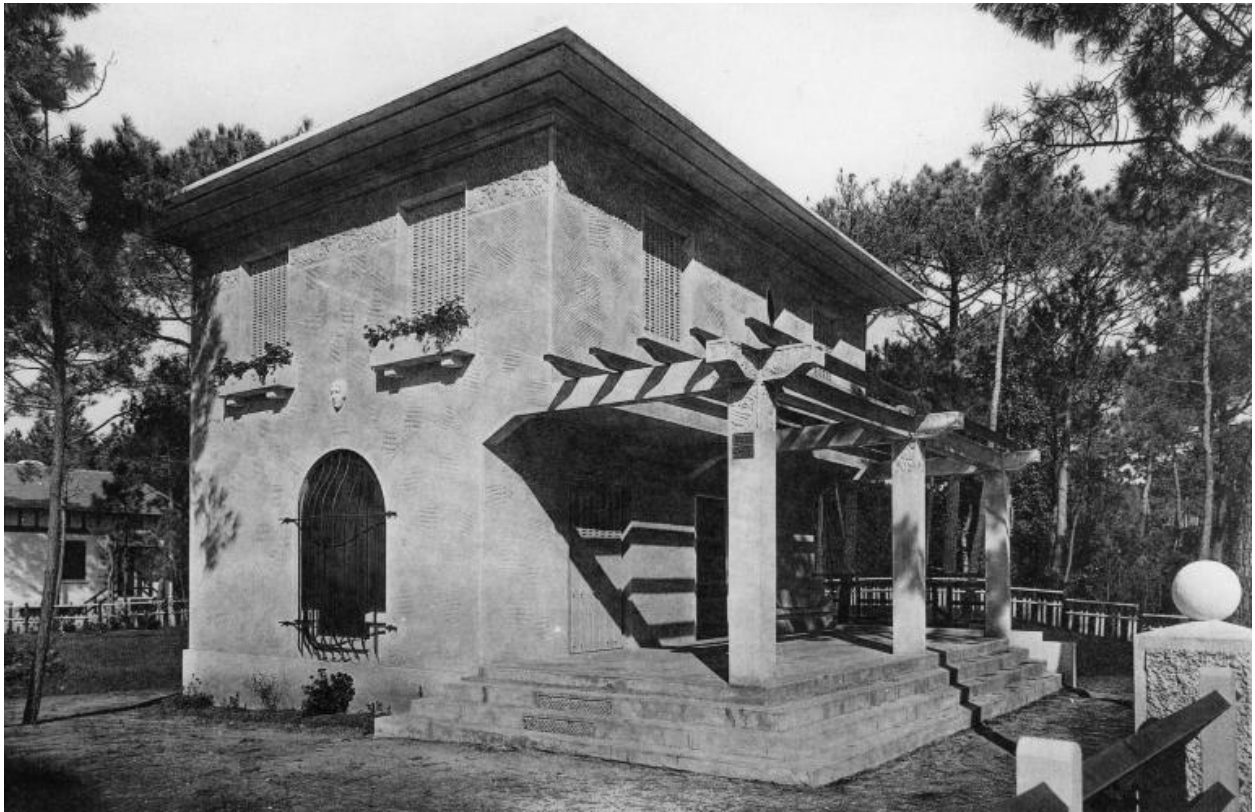
Façade sud de la villa Corinne puis Dauphine vue du sud-est.
