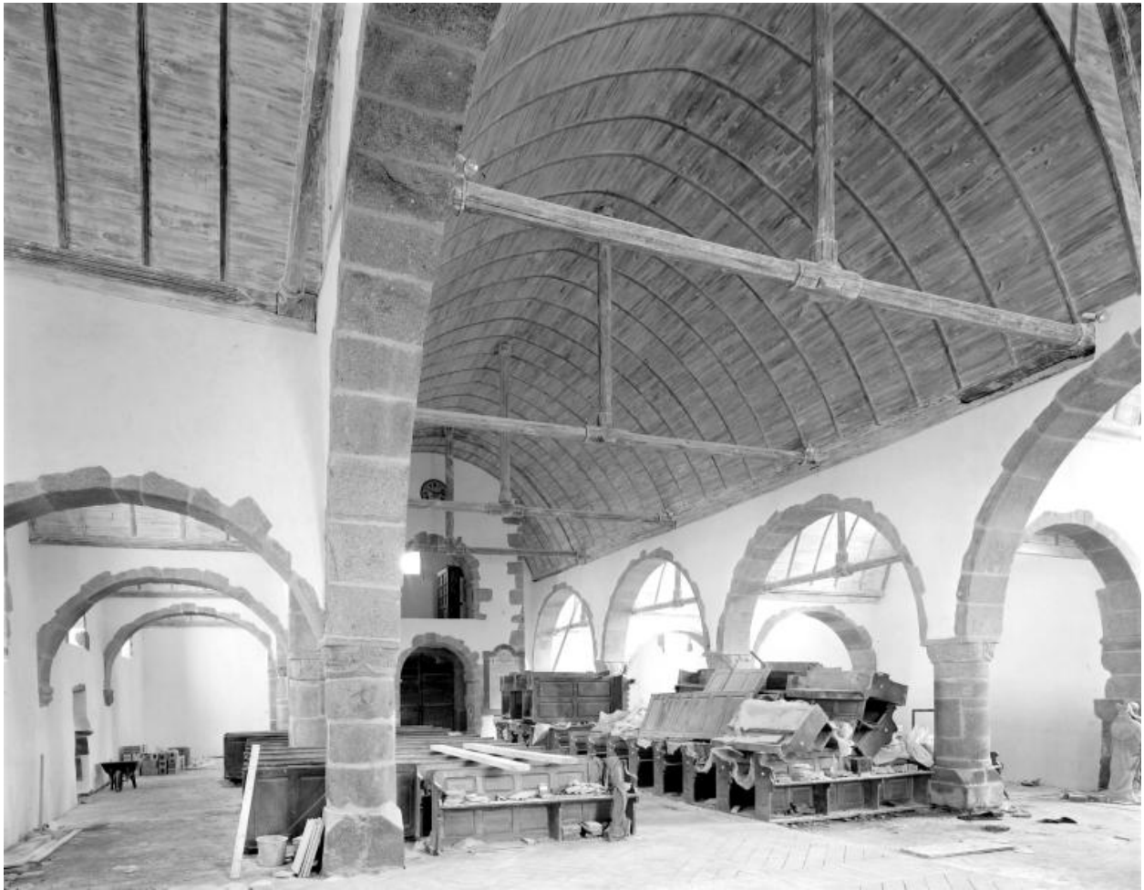
Vue de la nef depuis la chapelle sud, pendant la restauration de l'église.
