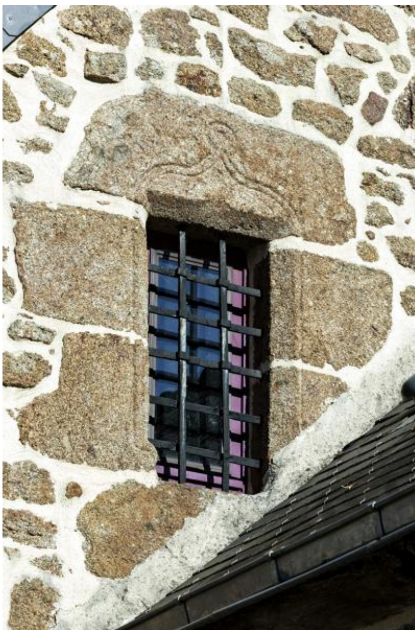
Fenêtre dans le pignon sud.
