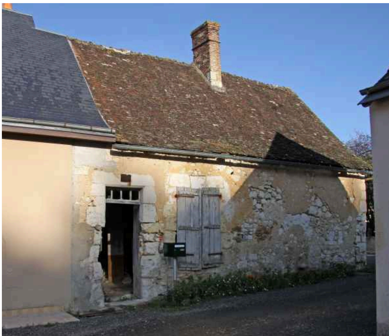
Façade antérieure sur cour.
