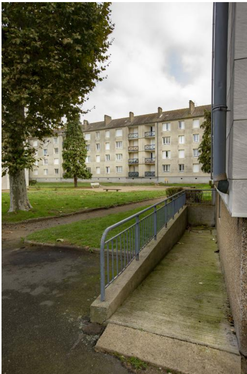
Vue des espaces collectifs avec une barre de la première tranche au fond.
