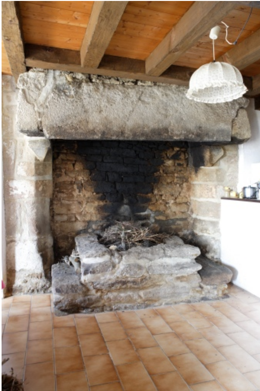
Vue de la cheminée (4 rue de l'Aha).
