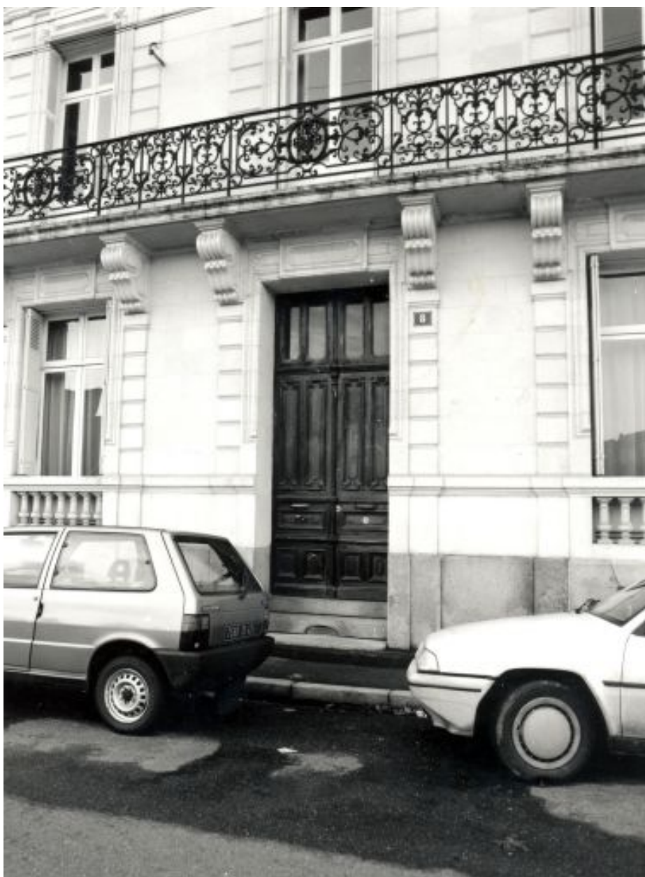
Porte d'entrée et balcon du premier étage.
