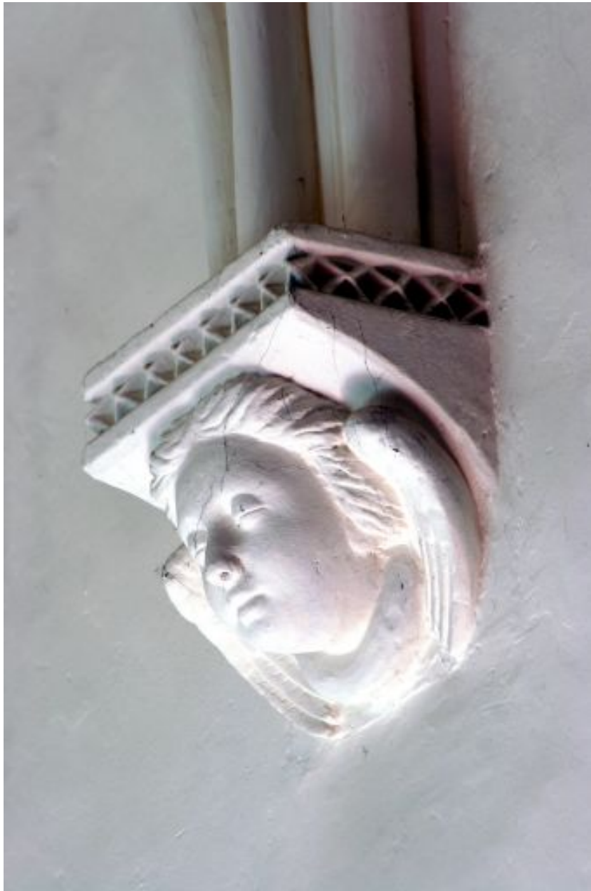
Voûte de l'abside : culot 3.
