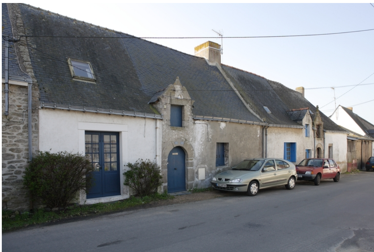
Vue d'ensemble des n° 15 à 21 rue du Rocher.
