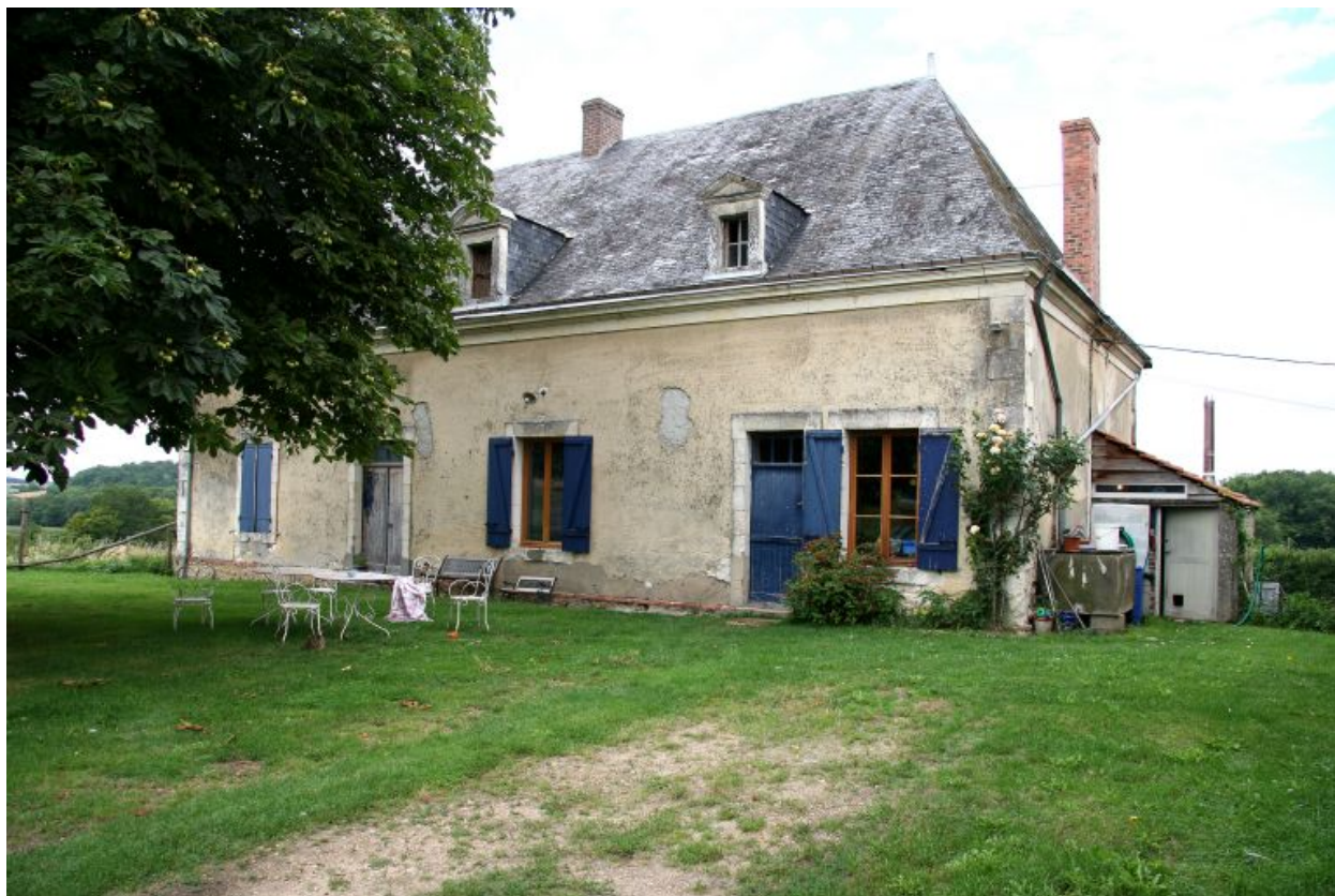
Maison : façade antérieure sur cour.
