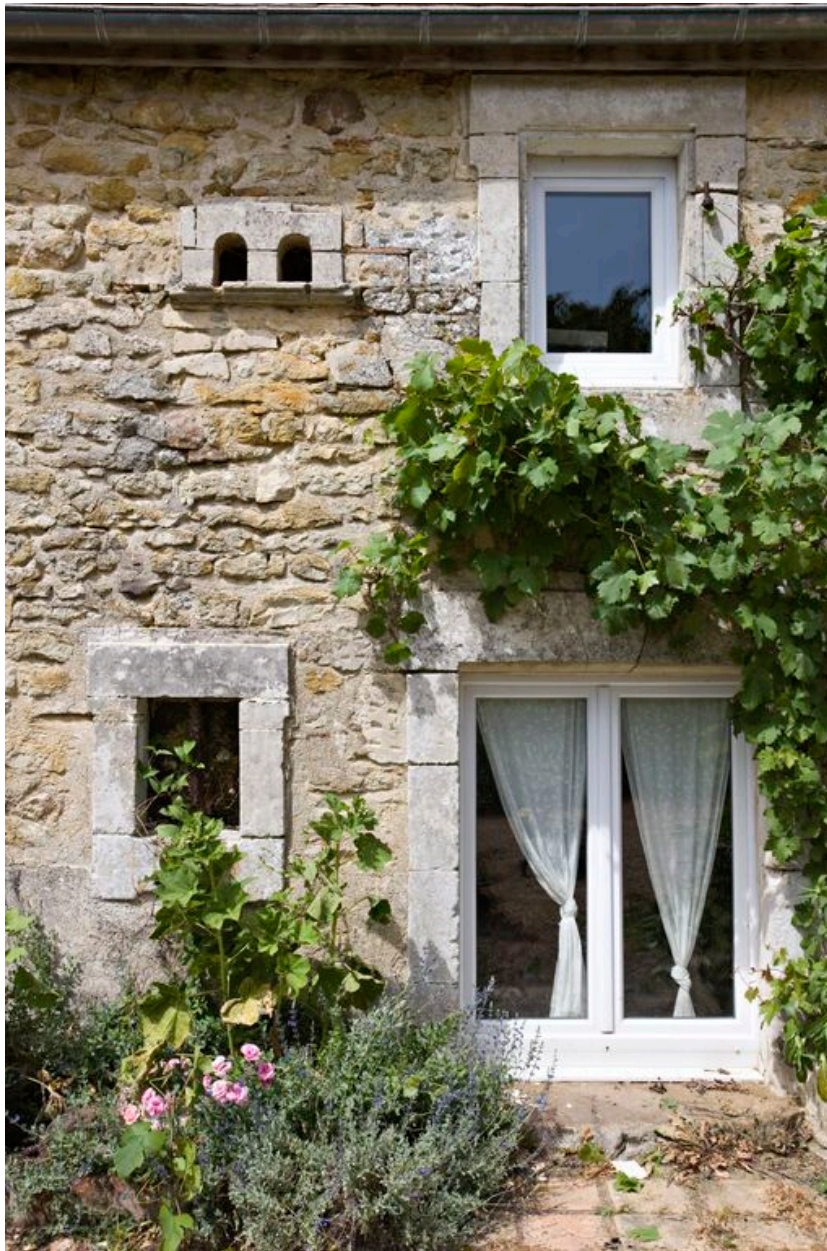
Détail de l'élévation antérieure
