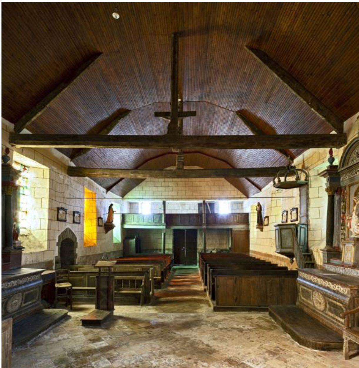
Nef vue depuis le chœur.
