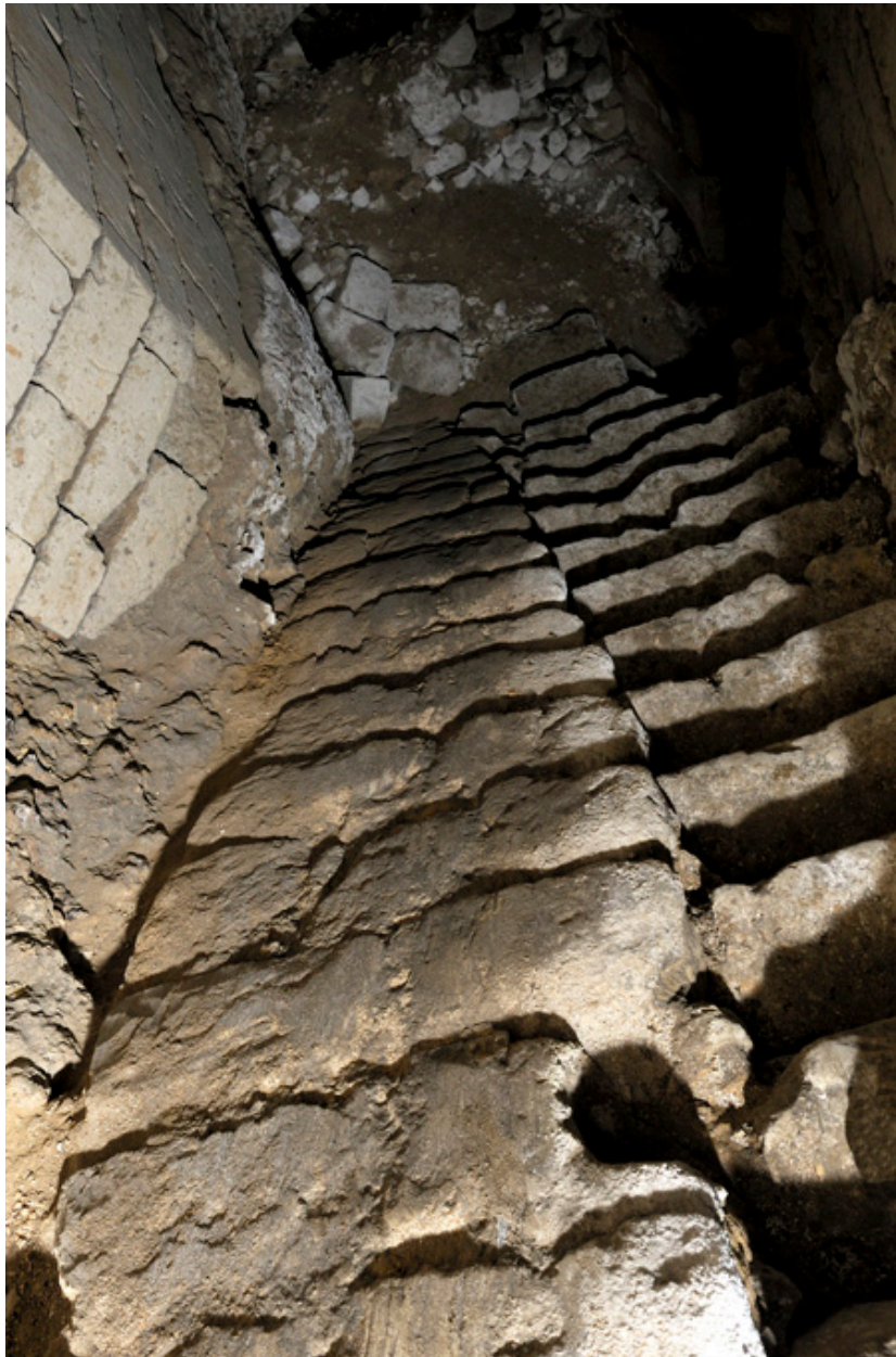
Détail de la rampe descendant au second sous-sol : traces d'usure par frottement.
