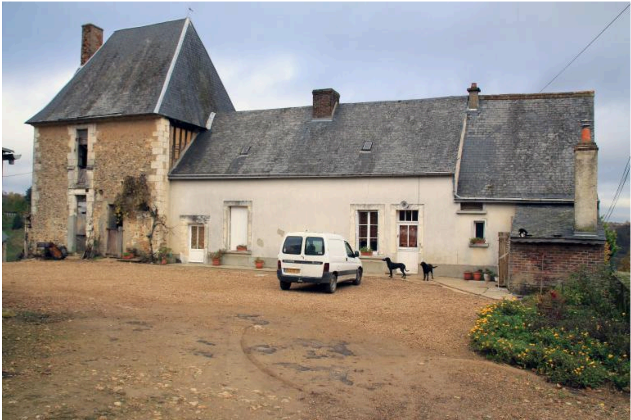
Vue d'ensemble du pavillon et de la maison, côté cour.
