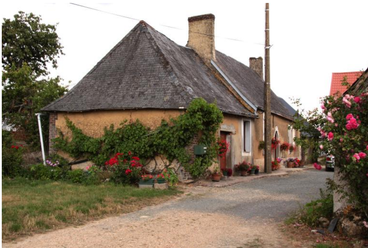
Vue de volume de la grande maison.
