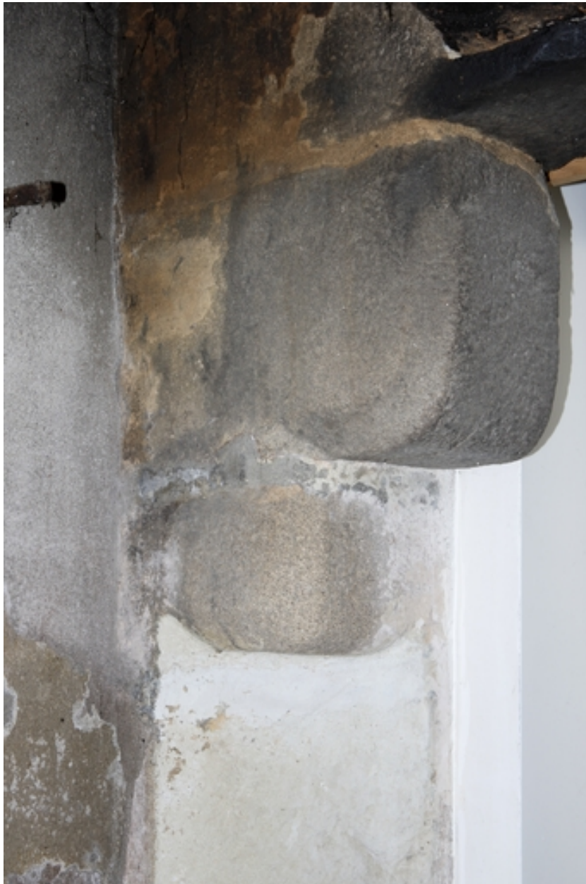
Rez-de-chaussée. Extension. Détail de la console de droite de la cheminée.
