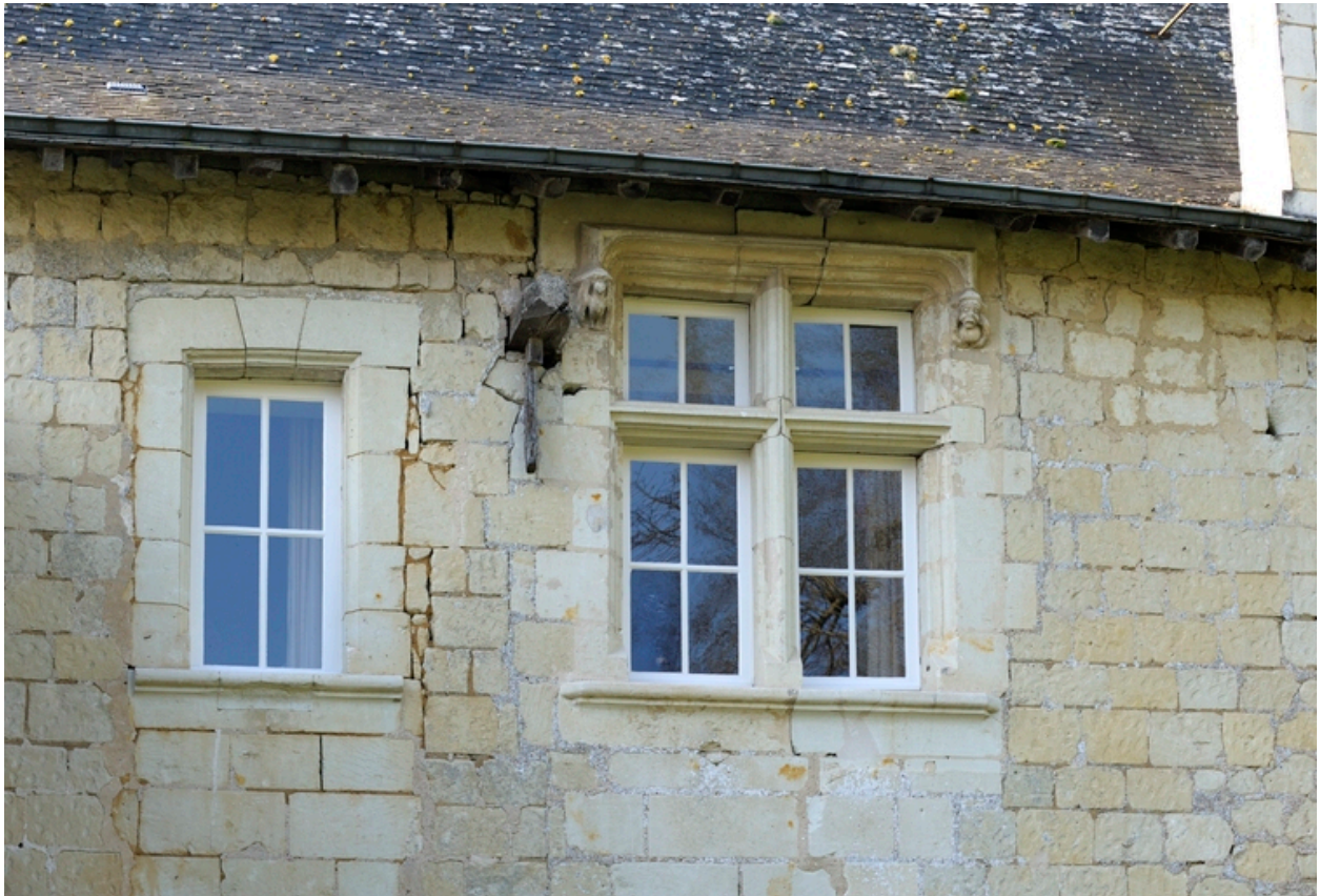
Logis. Manoir médiéval. Façade nord, fenêtres hautes (est), avec baie XVIIe ou XVIIIe siècle et croisée sans doute du début du XVIe siècle.
