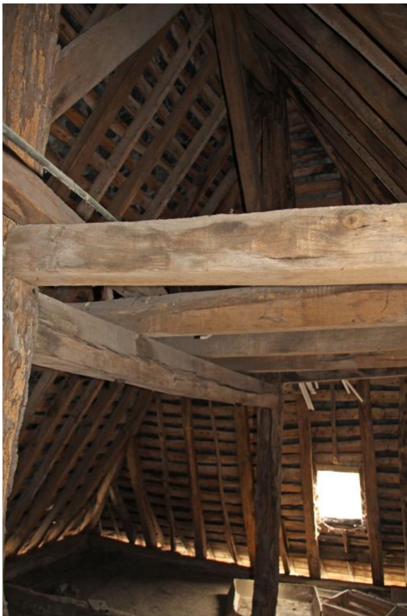
Détail de la charpente.
