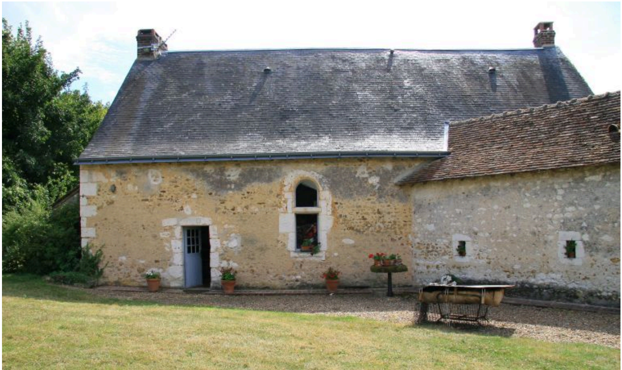
La maison : façade postérieure.
