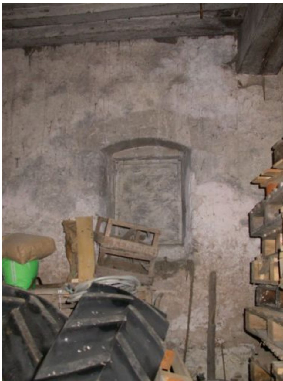
Grande salle : petite baie.
